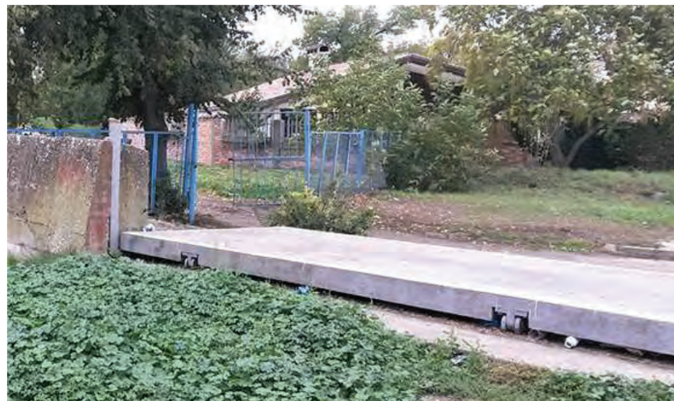
Разглобяемо защитно съоръжение на защитна стена срещу наводнения. Защитното съоръжение се сгъва, когато не се използва. (Видин, България)
