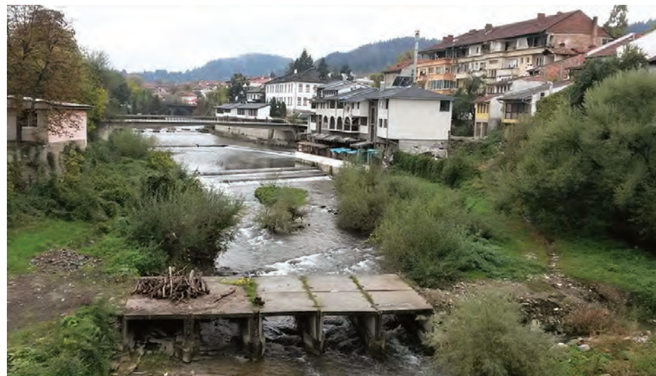
Поддържано речно корито. Вижда се разликата между разширеното речно корито и естественото речно корито след това (гр. Троян, България)
